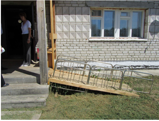
фото пандуса в доме престарелых в Бакcharском районе
